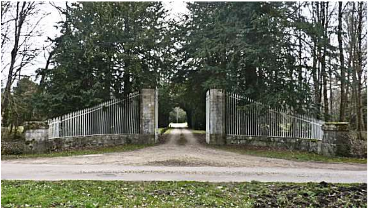
Entrée du château de Thurelles, état actuel (photo Marc Houbert)
