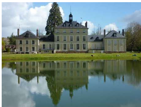
Façade OUEST sur pièce d'eau
