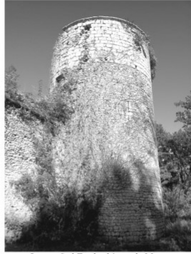
La tour Sud-Est du château du Mez
