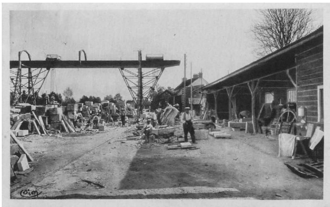
Carte postale du « Chantier de Pierres » à Souppes-sur-Loing
